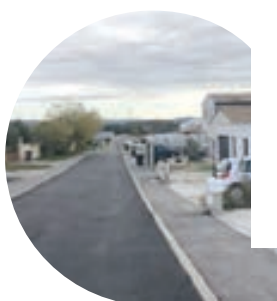
Revêtement et création de places de parking lot. Les Amandiers
