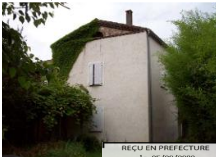
Façade isolée par l'extérieur en liège 16 cm, finition enduit chaux, cadres en bois pour accrocher les volets, Saint-Privat des Vieux,
