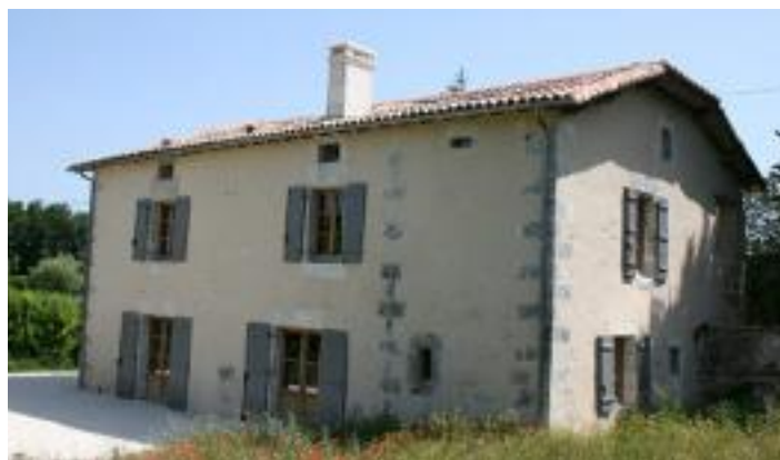
Enduit hygrothermique extérieur chanvre et chaux + finition chaux et sable local, autre région
