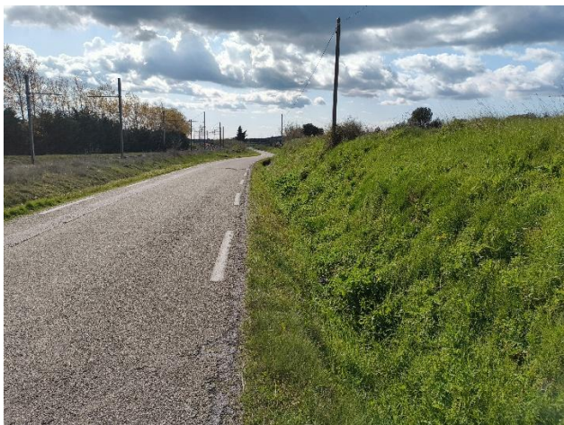
Fossé longeant la ZIP Ouest Source : ARTIFEX 2026
