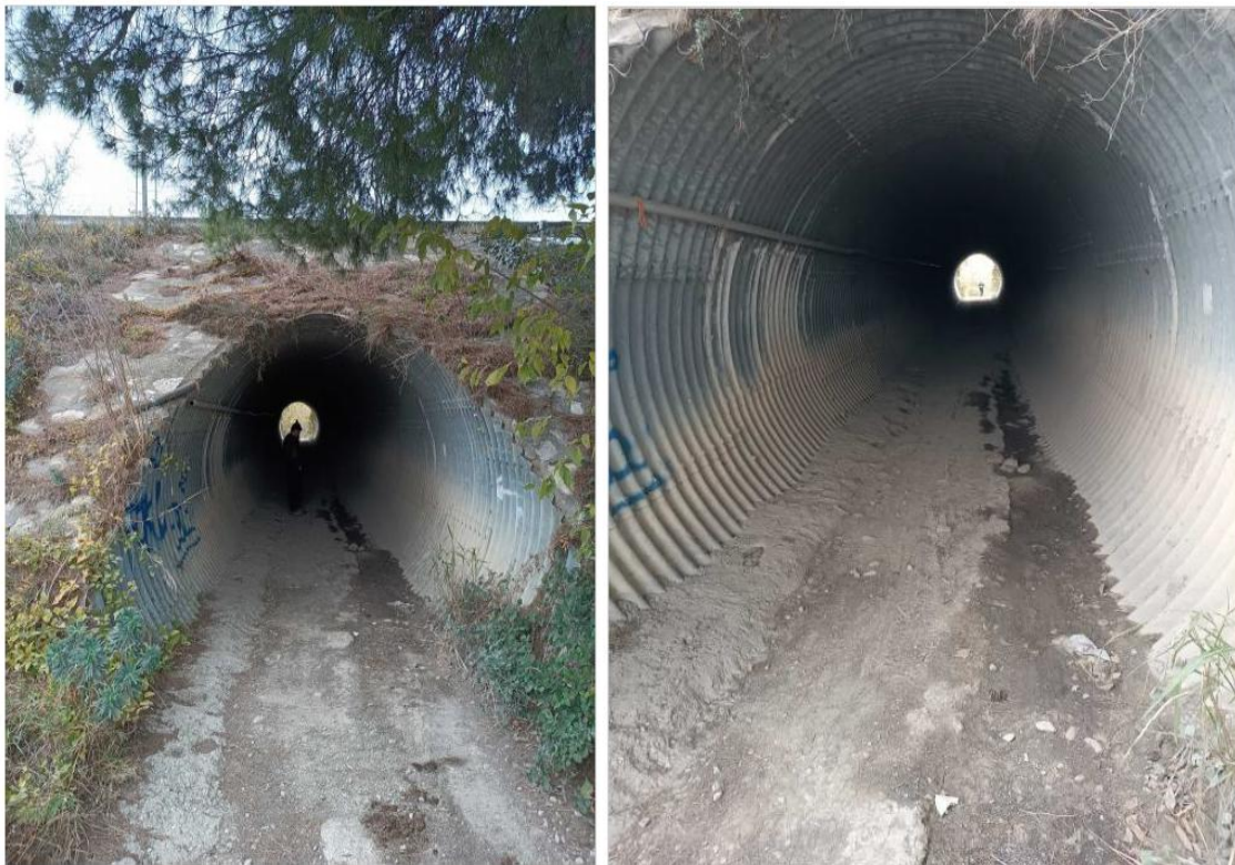
Figure 9: photos de l'ouvrage 17148 (FDC 30, décembre 2025)
