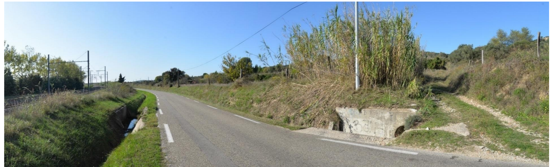
Vue d'état initial
