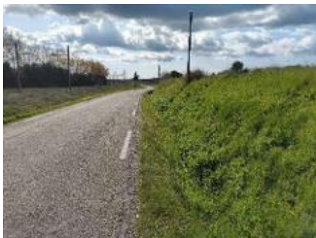
Fossé longeant la ZIP Ouest Source : ARTIFEX 2026
