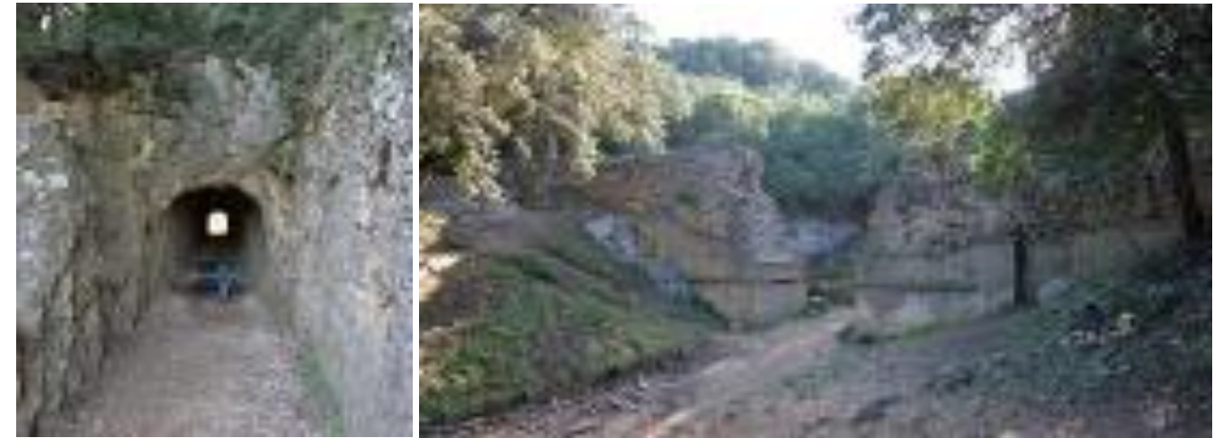
Vue 25 sur le tunnel et le pont de la Combe de Valmale
