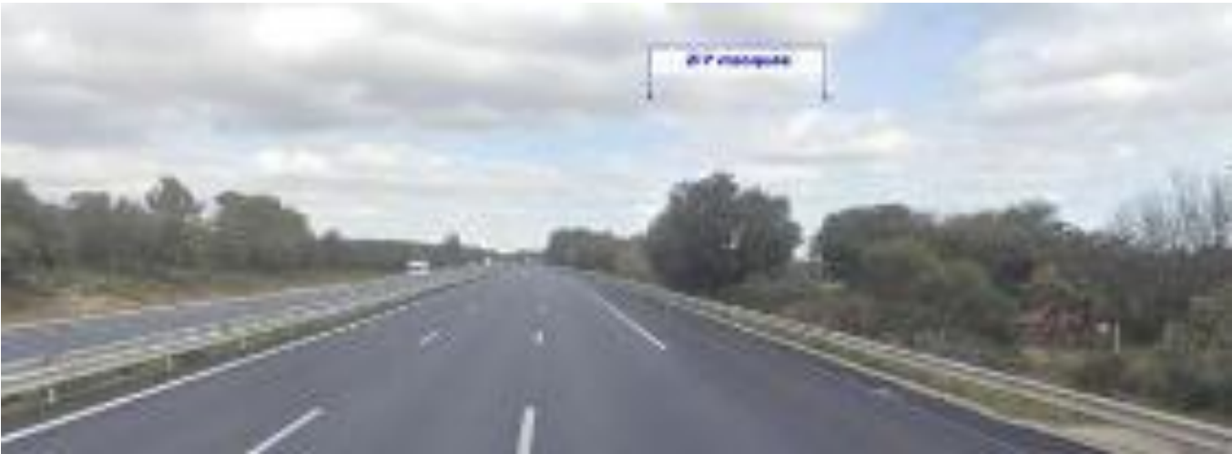
Vue 34 depuis l’A9 à hauteur du lieu-dit le Bosquet : La ZIP est masquée par la végétation de type garrigue basse qui borde ici la route.
