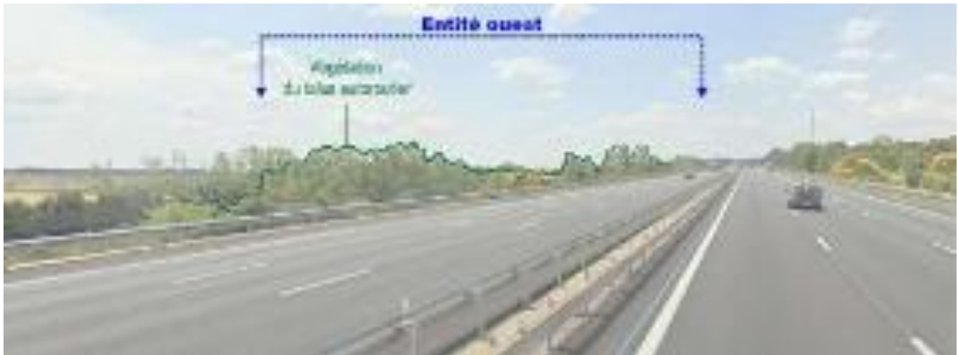
VUE 5b à hauteur du bassin de rétention vers l'entité ouest : La végétation du talus autoroutier masque le projet photovoltaïque.
