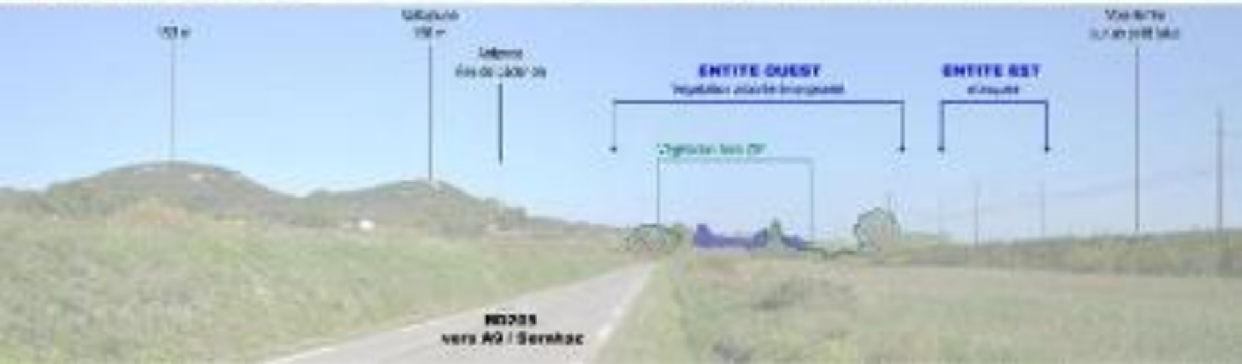
Vue 47 depuis la route RD205 entre la ZIP et la déchetterie : L'entité est est masquée par le talus ferré. La végétation arborée de l'entité ouest est partiellement visible.
