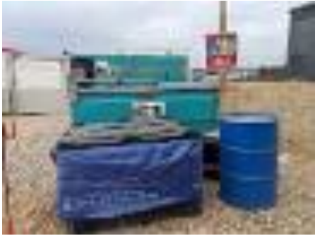
Tous les contenants de produits polluants doivent être placés sur des bacs de rétention ou sur une plateforme étanche adaptée (©NEOSOLUS Environnement, 2022)
