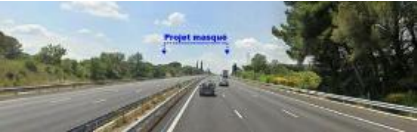
VUE 1a depuis l’autoroute A9 à mi pente du coteau en rive droite du Gardon
