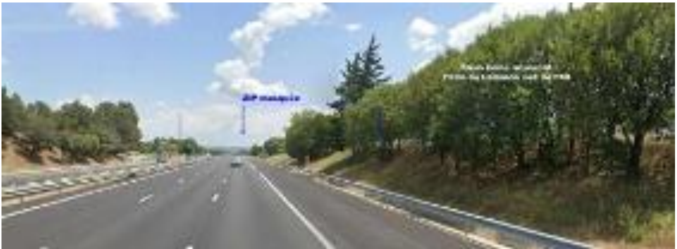
Vue 32 depuis l'A9 à hauteur de l'aire de Lédenon sud : La ZIP est masquée par la végétation de l'aire.
