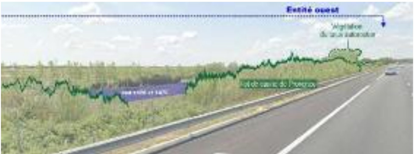
VUE 6b à hauteur de l'entité ouest (partie est) vers l'ouest : La discontinuité dans le linéaire de végétation du talus autoroutier occasionnera des vues partielles sur l'arrière des panneaux photovoltaïques de l'entité ouest.
