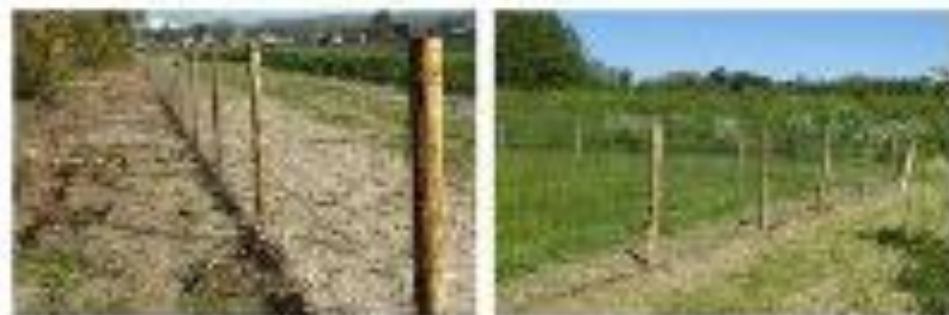
Figure 16 : Exemple d'une clôture de parc solaire (Source : MELVAN).
