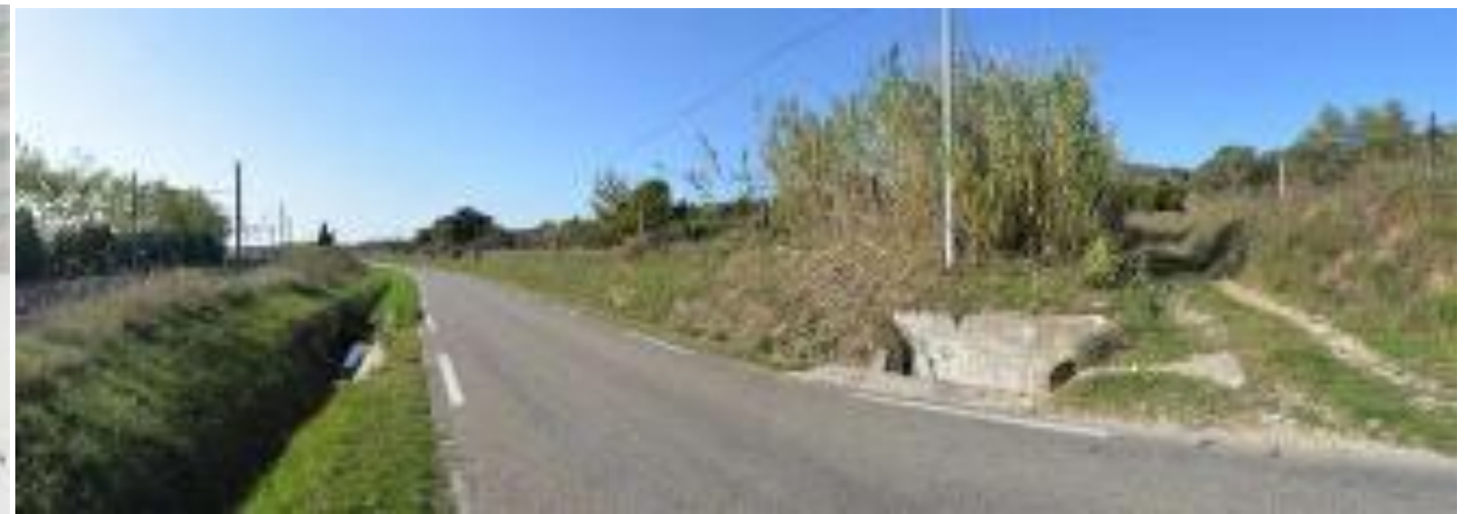
Vue d'état initial
