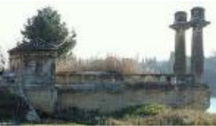
Vue 21 sur une des culées de l'ancien pont suspendu (Source : https://monumentum.fr/ )
