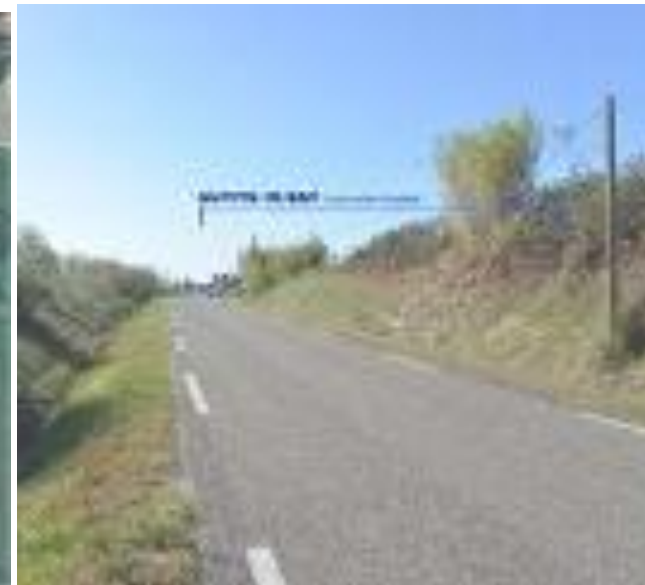
VUE A1 vers l'entité ouest : Elle est en grande partie masquée par le talus, ses ronciers et ses îlots de canne de Provence
