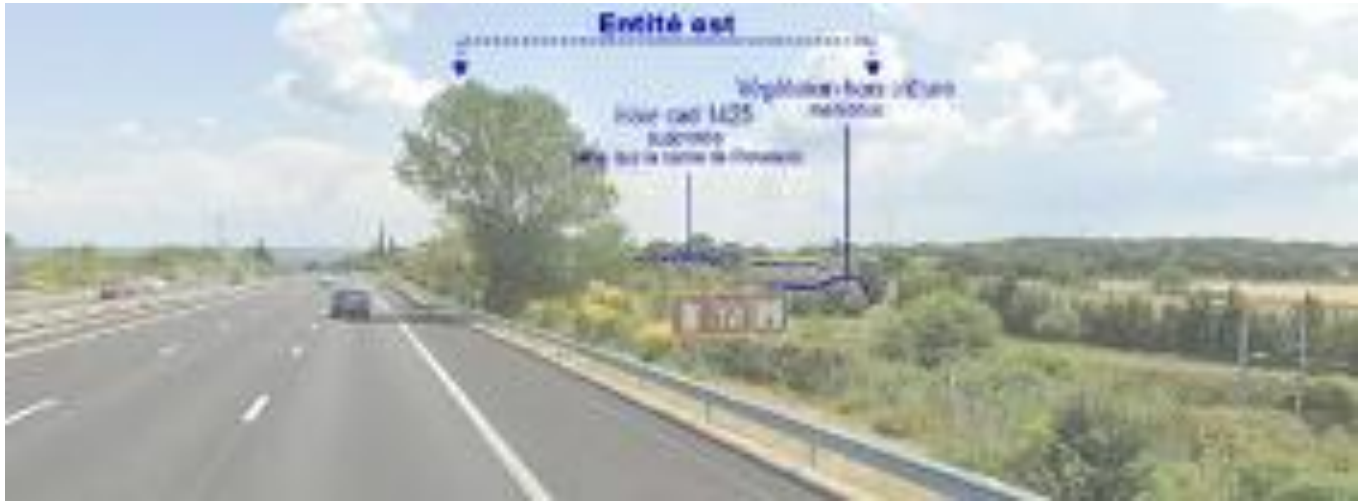
VUE 5a à hauteur du bassin de rétention vers l'entité est : Les hauteurs de certaines tables photovoltaïques pourront encore être visibles. La végétation des abords de l'autoroute A9 va progressivement masquer l'entité est.
