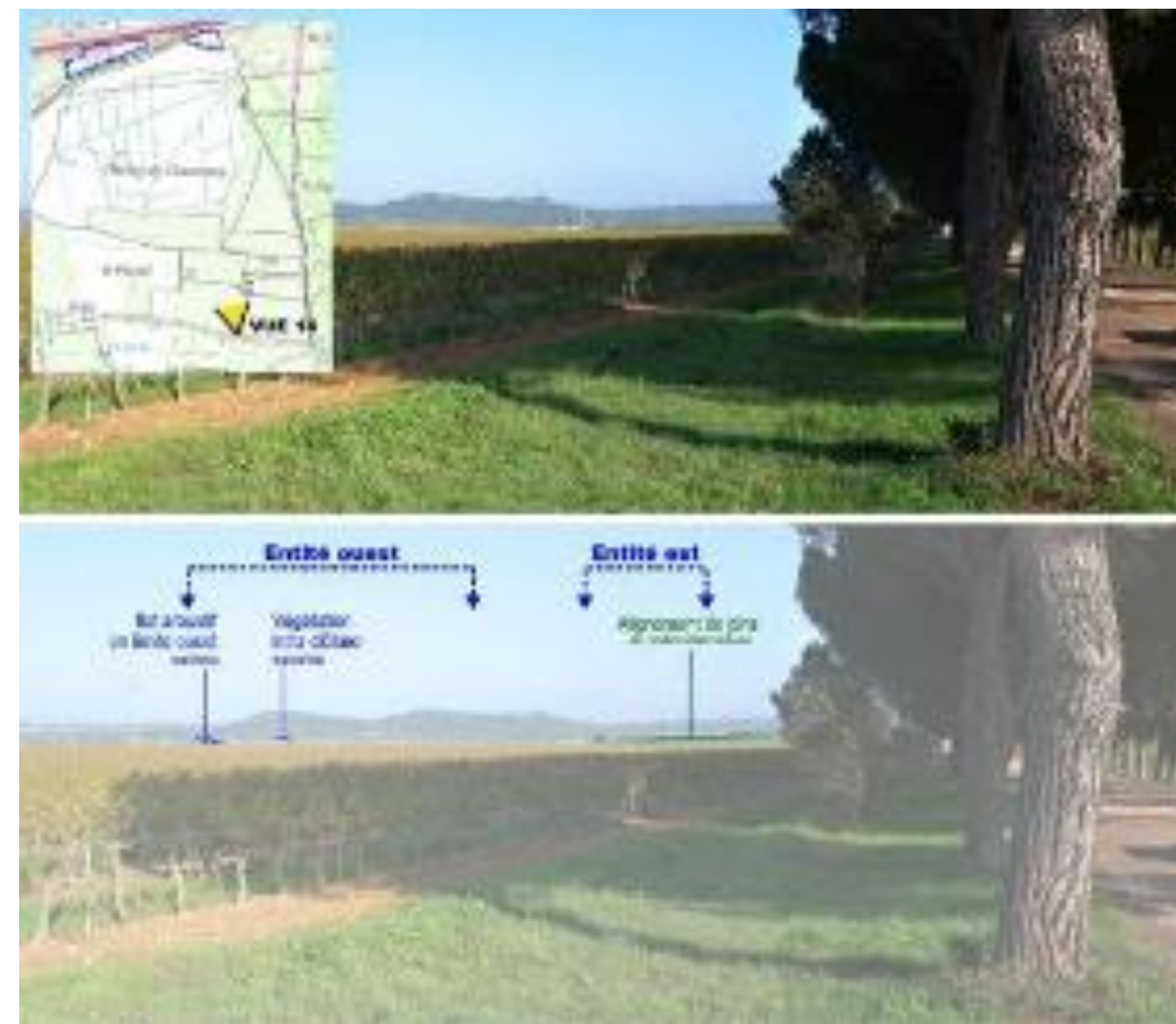
VUE 14 depuis la route RD500 à hauteur du Mas de Clausonne : Les panneaux photovoltaïques sont masqués par la vigne et le léger bombement du relief.
