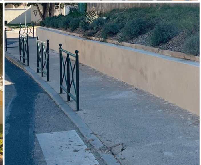
Rénovation mur entrée du village
