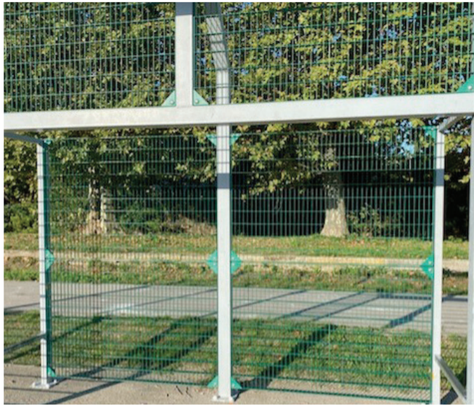
Rénovation du City Ball
