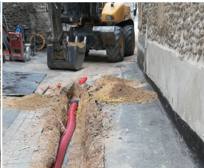
Renforcement électrique rue des Ecoles
